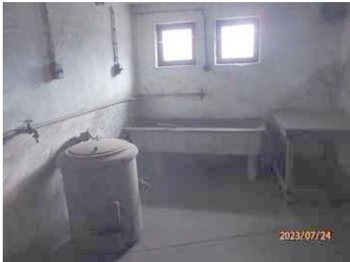
sklepy bývalá prádelna
